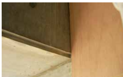
打ち放し養生（薄ベニア）
