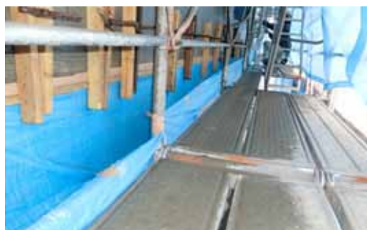
溝型の下部養生 その4
