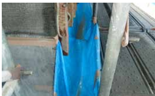
溝型の下部養生 その3
