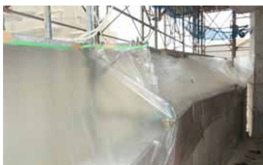
溝型の下部養生 その5（手すり等）
