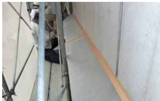
下部養生（プラベニア）
