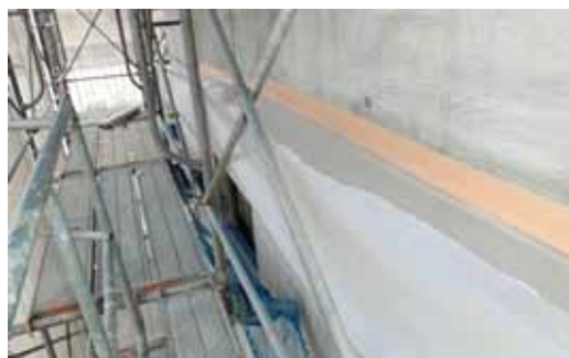
溝型の下部養生 その2
